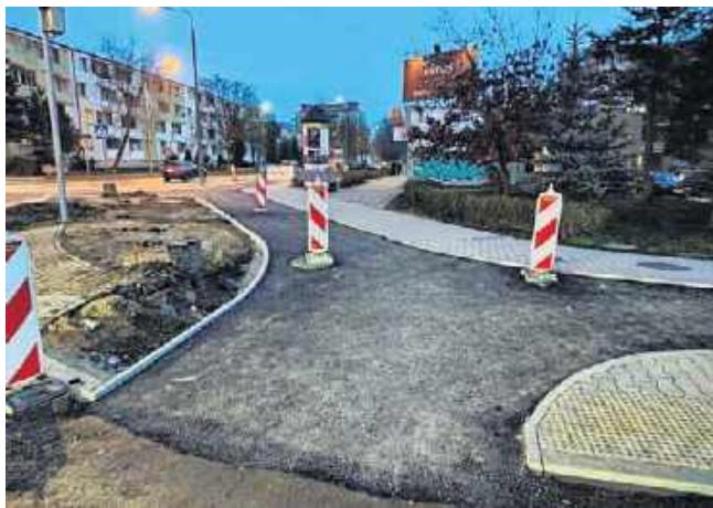
Leży już pierwsza warstwa asfaltu na powstającej drodze dla rowerów na ulicy Chrobrego
