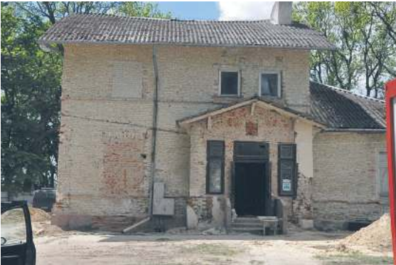
Dworek przed remontem
