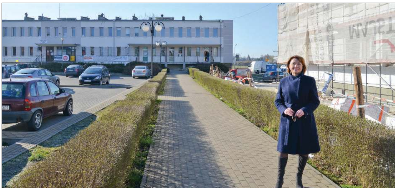
■ Burmistrz Beata Siedlecka ma nadzieję, że termomodernizacja budynków Samodzielnego Publicznego Zakładu Opieki Zdrowotnej i Urzędu Miasta pozwoli na obniżenie kosztów zużycia energii
