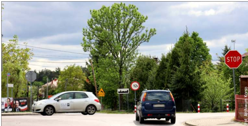
Na skrzyżowaniu w Przyłęku często dochodzi do wypadków.
