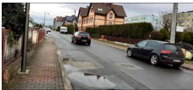
Po przebudowie będzie tu ścieżka pieszo-rowerowa.
