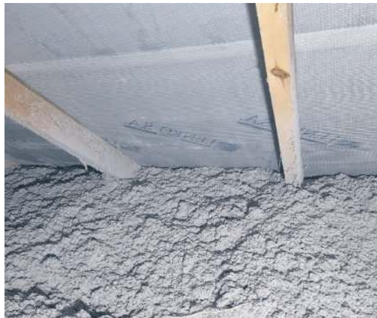
Przed... i po dociepleniu wełną celulozową
