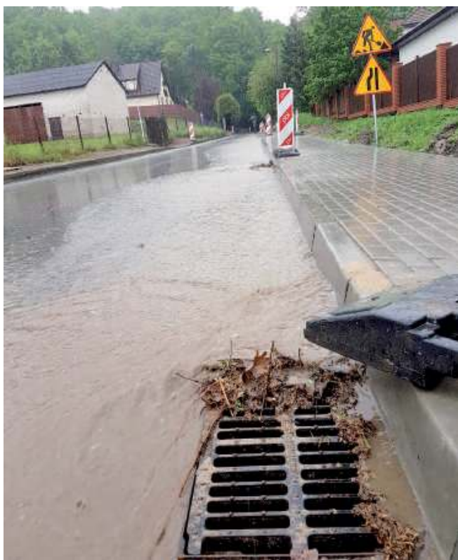
To zdjęcie wykonali mieszkańcy Parchatki podczas jednego z ostatnich deszczy. Tak burtowała woda z góry z drogi do Zbędowic i spływała na chodnik i posesję
