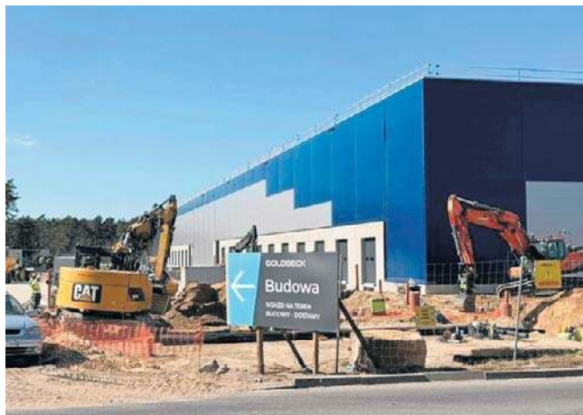
Budowa nowej hali w Bydgoskim Parku Przemysłowo-Technologicznym
