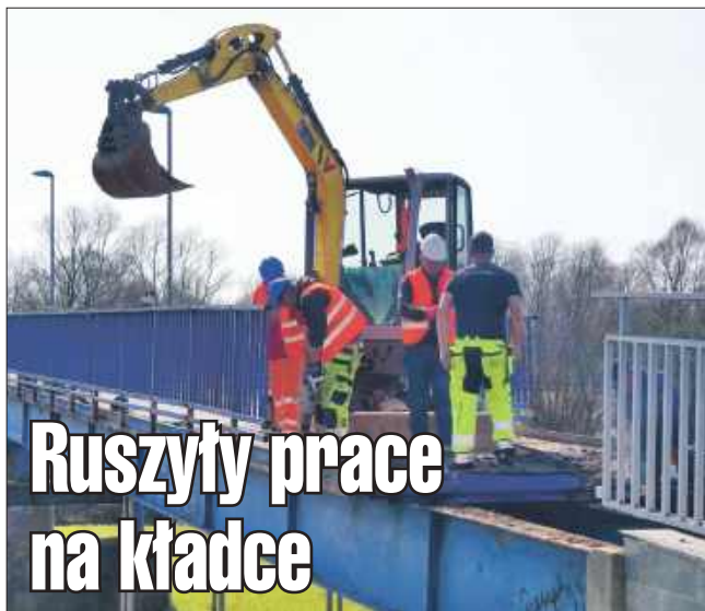
Trwa demontaż elementów kładki.
