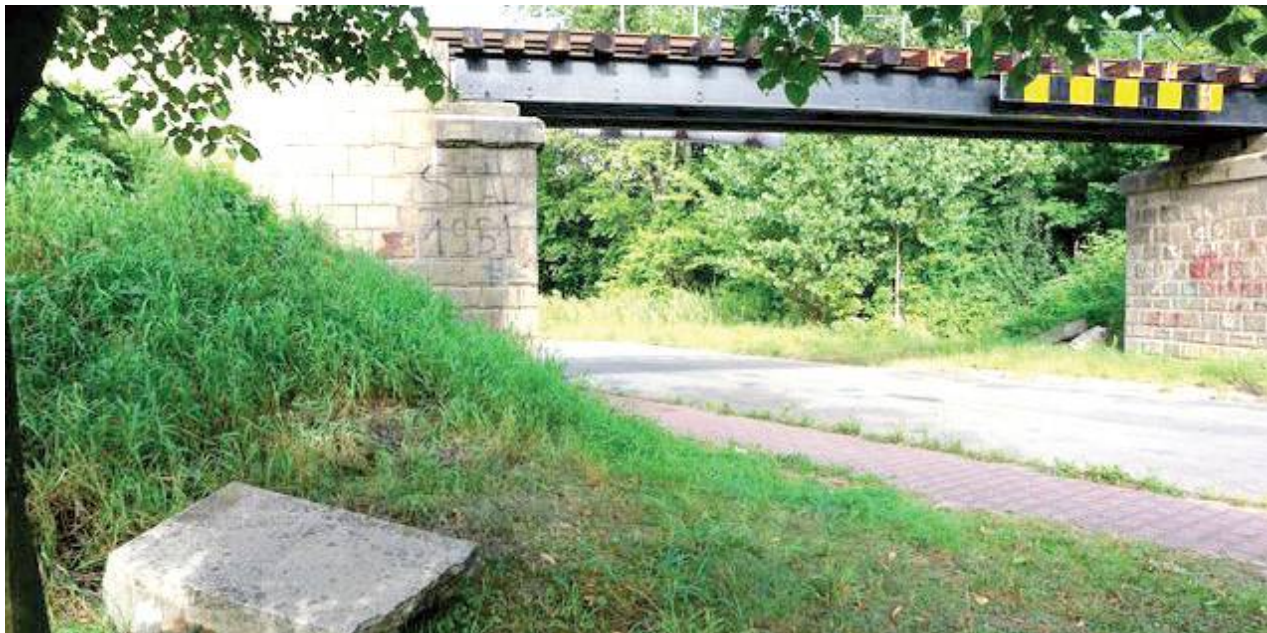
Siła uderzenia była bardzo duża. Jeden z elementów betonowych, który odpadł, trzeba było przesunąć koparką
