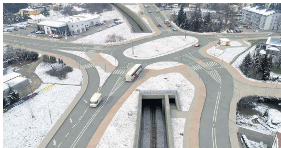
Powstaną dwa tunele kolejowe: dłuższy będzie miał 250 metrów, krótszy - 84 m.
