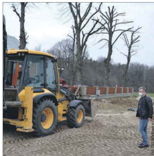
25 marca z postępowaniem prac w miejscu budowy zapoznał się przewodniczący Rady Gminy Wadowice Górne - Krzysztof Maciejak.
