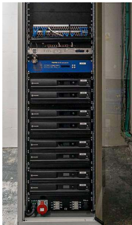
Sygnał do wszystkich zestawów płynie z dedykowanych im wzmacniaczy serii L marki Dynacord, które są zainstalowane w amplifikatorni nad sceną.
