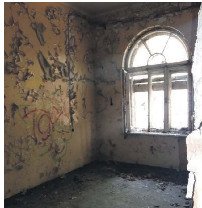
... jedno z pomieszczeń dla pacjentów
