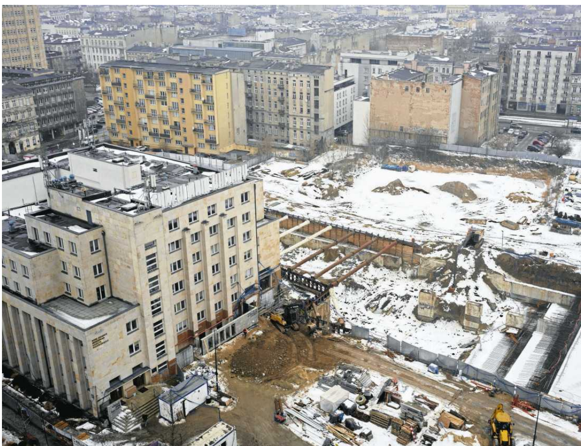
• Budowa komory dla tunelu Kolei Dużych Prędkości, 27 stycznia 2026 r. FOT. MARCIN STĘPIEN / AGENCJA WYBORCZA.PL
