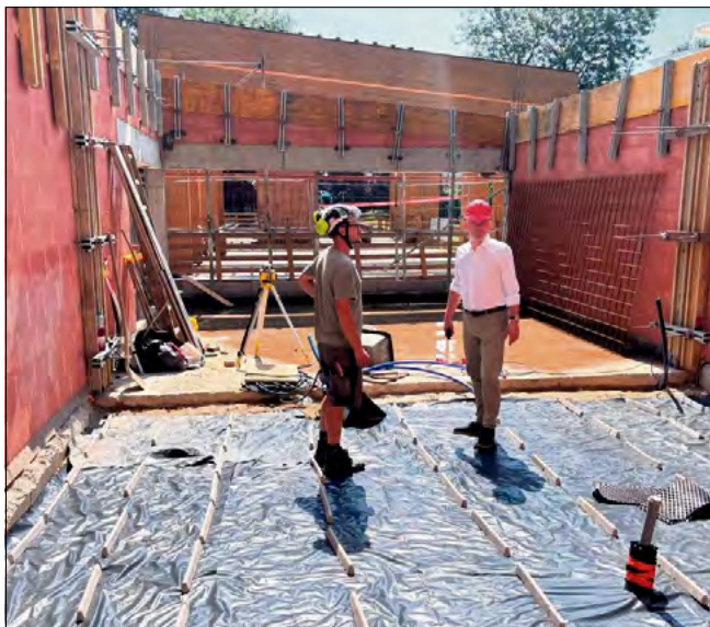
W ostatnim czasie plac budowy odwiedził burmistrz Gogolina Krzysztof Reinert, który przyjrzał się postępowi robót.
