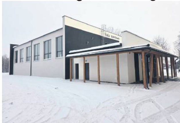
Budowa hali kosztowała 3 mln 369 tys. zł brutto.
