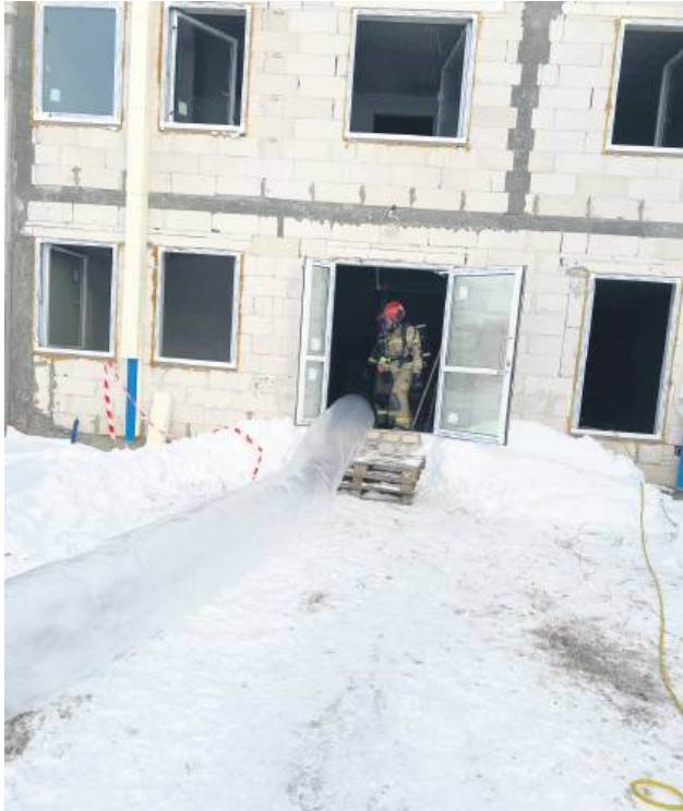
Specjalistycznymi antywybuchowymi wentylatorami odessano cały gaz, który uleciał z instalacji w piwnicy biurowca w Lipinie.
