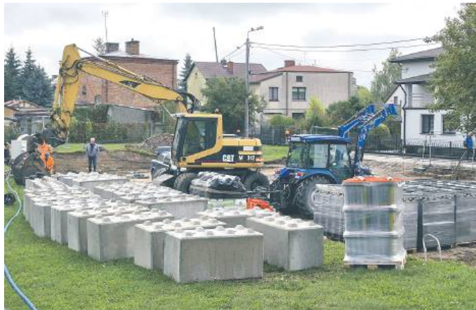
Przy SP nr 3 prace związane z budową hali już się rozpoczęły
