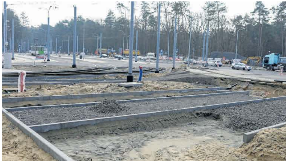
Przebudowa obejmie ulice dojazdowe do ronda oraz ul. Kupczyka aż do granic miasta. Powstanie też ścieżka rowerowa oraz parking park & ride
