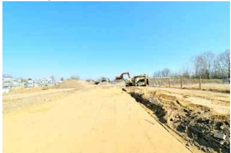
Obwodnica pobiegnie od ronda w pobliżu dawnego Tesco, przez budowany właśnie odcinek na ul. E. Orzeszkowej i dalej do granic miasta
