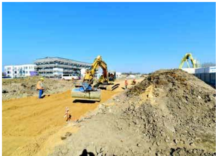
Trwa budowa odcinka północnej obwodnicy miasta
