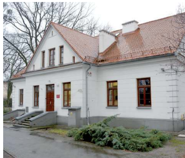
Około dwustuletni budynek do czerwca poprawi swój wygląd. Ma być m.in. skutecznie zabezpieczony przed wilgocią
