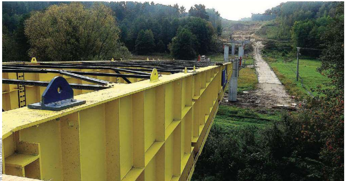
Budowa mostu nad rzeką Wel w pobliżu wsi Kaczek
