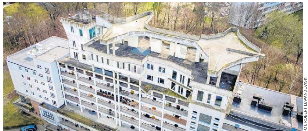
Część nadbudowy została już rozebrana
