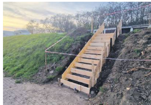
Nowe schody poprawią bezpieczeństwo i wygodę mieszkańców
