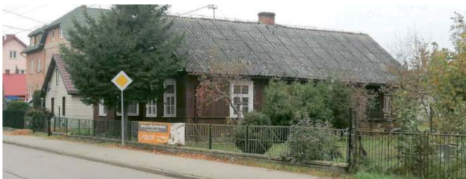
Kwestia własności nieruchomości przy ul. Cmentarnej 1 ciągle nie jest rozstrzygnięta
