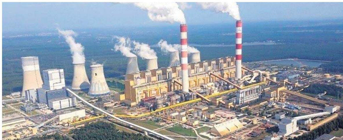
Elektrownia Bełchatów z lotu ptaka. Wkrótce w Bełchatowie może powstać elektrownia atomowa
