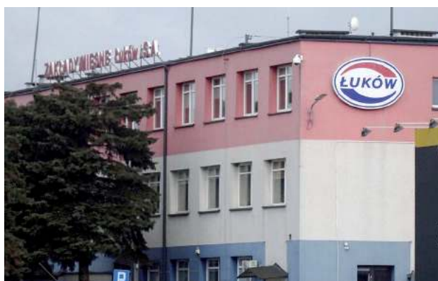
Zarząd Zakładów Mięsnych w Łukowie wydał oświadczenie, w którym informuje, że powołane do tego instytucje i organy prowadzą postępowania wyjaśniające oraz odmawia przedstawienia szczegółowych okoliczności związanych z przebiegiem wypadku
