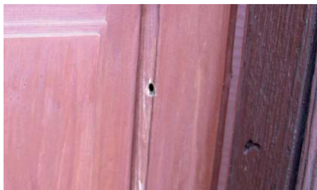
Otwór wlotowy po zewnętrznej stronie drzwi
