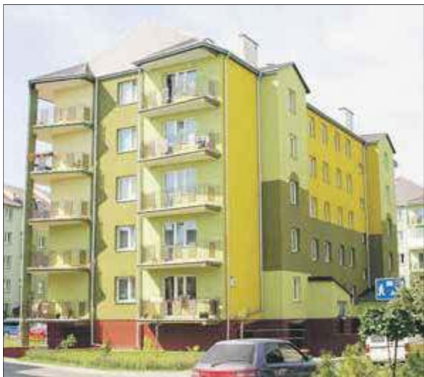
Firma ma wieloletnie doświadczenie w wykonawstwie budynków wielorodzinnych o różnym standardzie wykończenia
