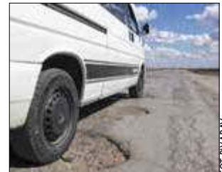
Droga gminna w Nowych Litewnikach i droga powiatowa na odcinku Horoszek Duże – Serpelicę wkrótce odzyskają dawną zapomnianą świetność
