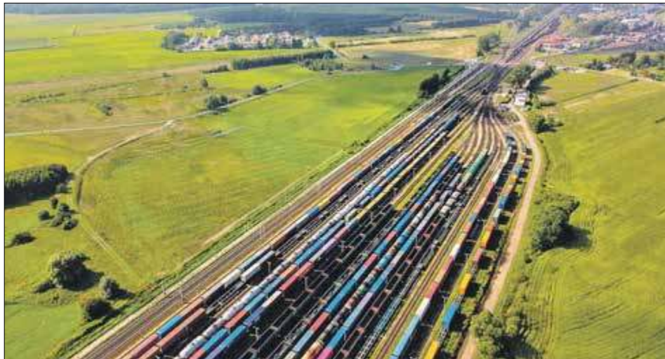
Budowa Parku Logistycznego Małaszewicze ma potrwać ok. 5-6 lat, jej szacowany koszt to 3,2 mld złotych
