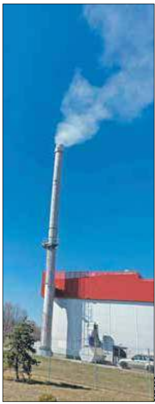
Ciepłownia rozpoczęła prace w kwietniu tego roku. Jej budowa trwała od jesieni 2018.
