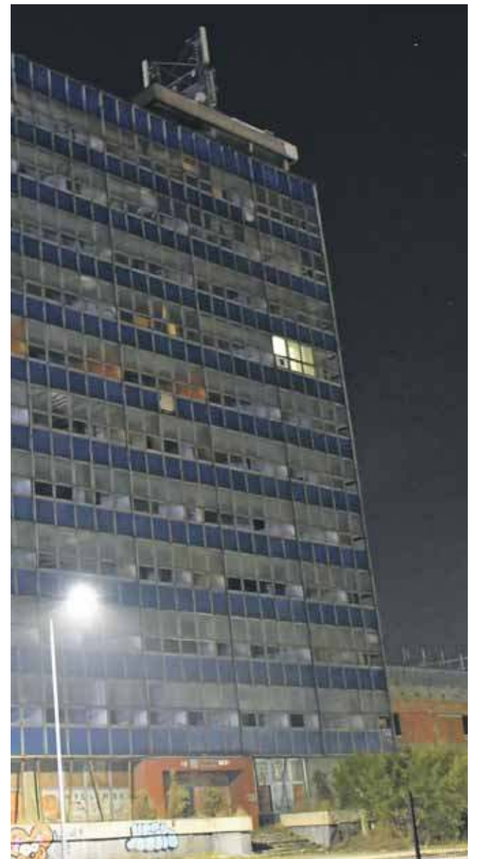
Mieszkańców zaniepokoiło palące się w pomieszczeniu na jednym z wyższych pięter światło
