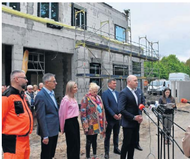
Budowa nowej stacji pogotowia ratunkowego przy ul. Juliana Fałata ma być gotowa wiosną 2027 roku.
