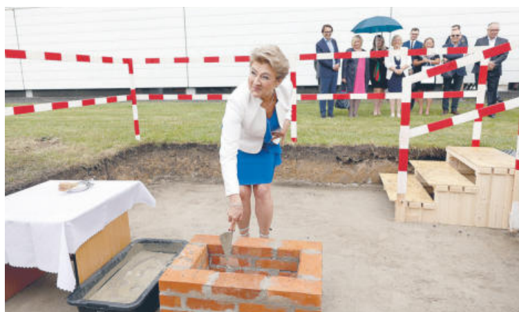
Prezes PEC Marzena Komar wmurowuje kamień węgielny pod przyszłą budowę.
