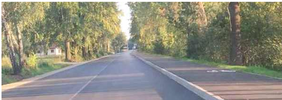
Tak wygląda odcinek przebudowany przez PRD Lubartów
