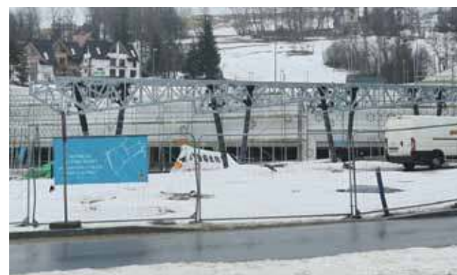
Tak parking przy powstającym centrum komunikacyjnym wyglądał we wtorek. Ma być zakończony w czerwcu.
