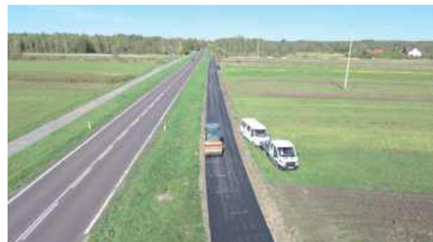
Roboty w Kolonii Sokołówka są prowadzone na odcinku o długości 1310 metrów
