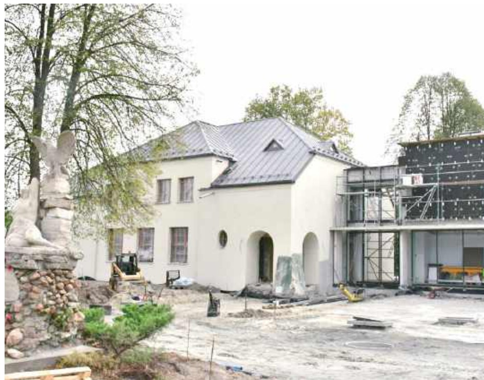
Przebudowa obejmuje remont dotychczasowego budynku dawnej szkoły oraz budowę nowego pawilonu
