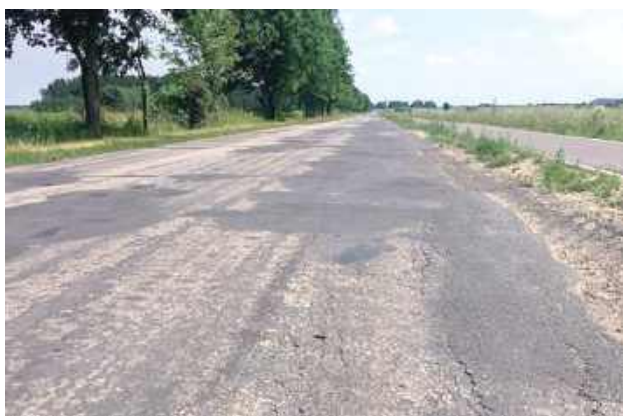
Jeszcze tej jesieni rozpocznie się przebudowa dróg w Siedliskach i w Hamerni
