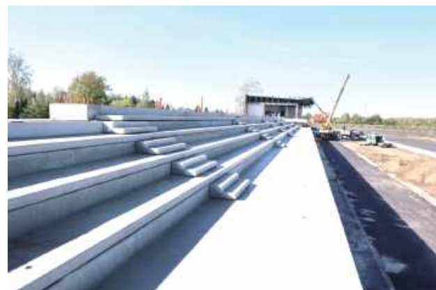
W trakcie I etapu przebudowy autodromu zostanie wybudowana jedna z trybun
