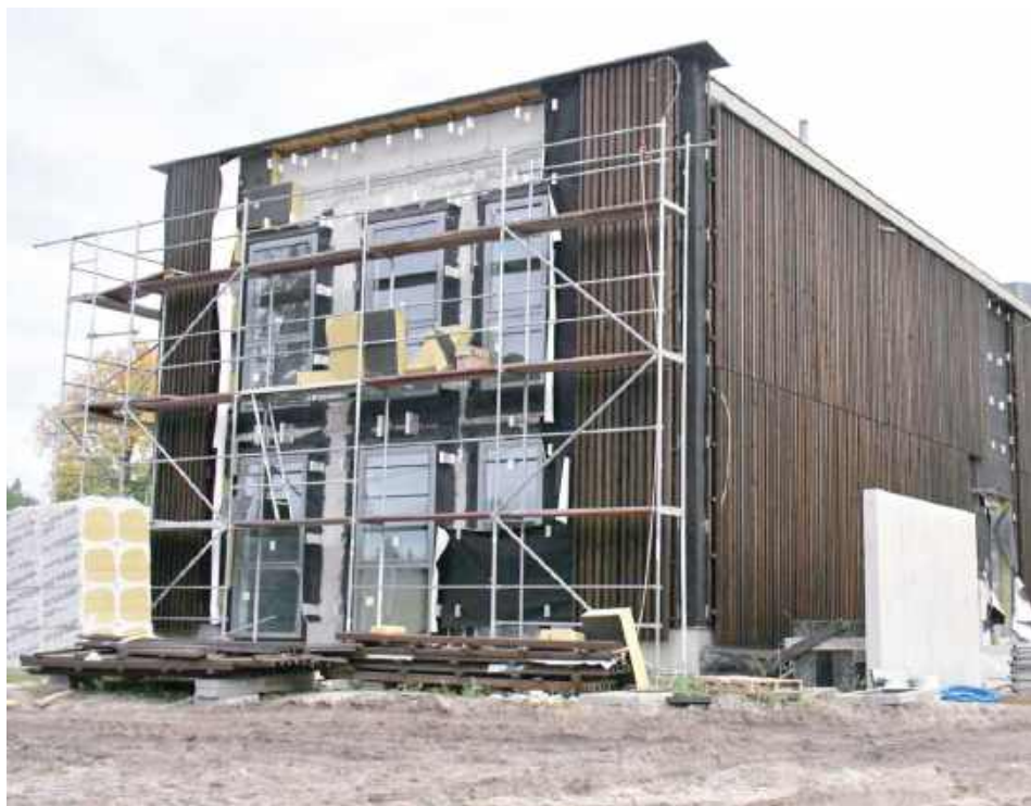
Roboty budowlane mają się zakończyć przy końcu listopada br.
