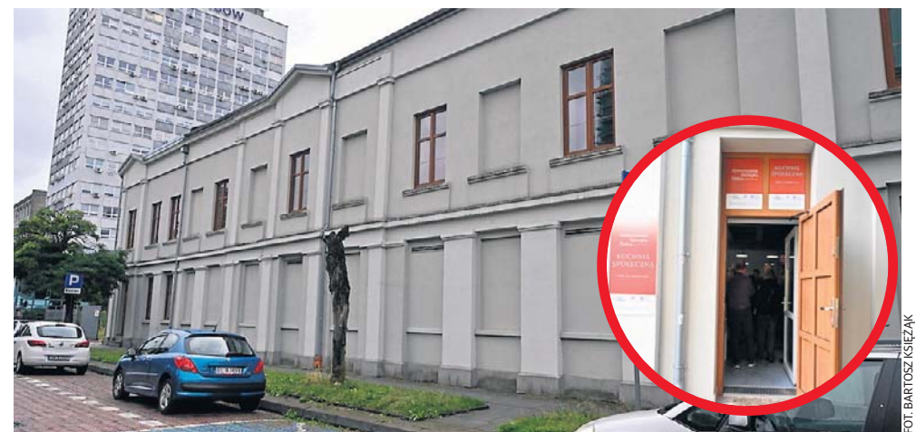
Kuchnia społeczna będzie się mieścić w tym budynku przy ul. św. St. Kostki.
