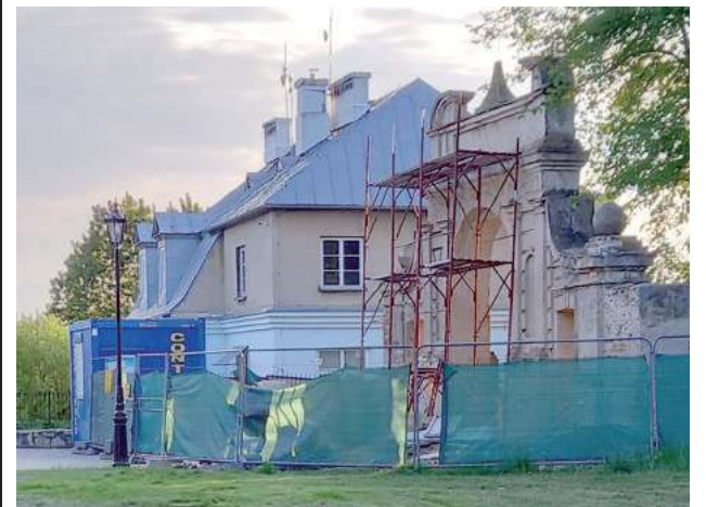
Zakończył się trwający od kilku miesięcy remont konserwatorski bramy wjazdowej w Zespole Pałacowo-Parkowym w Zawieprzycach
