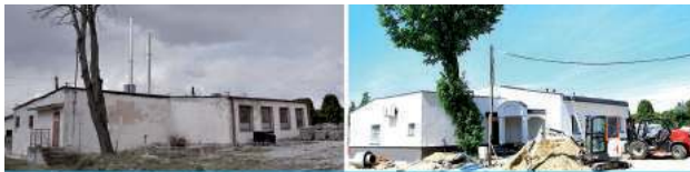
Na potrzeby domu seniora adaptowano budynek należący do dawnego kompleksu szpitalnego
