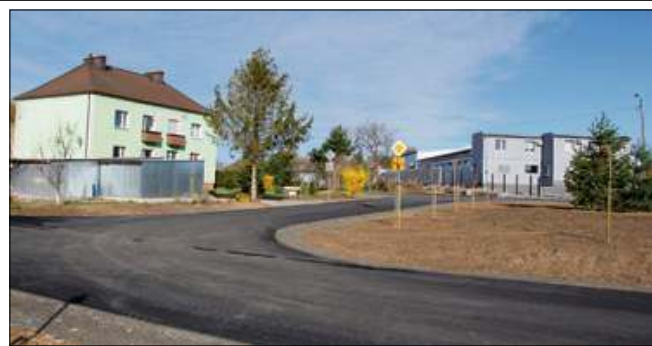
Nowa nawierzchnia ułatwi dojazd mieszkańcom oraz pracownikom okolicznych firm.
