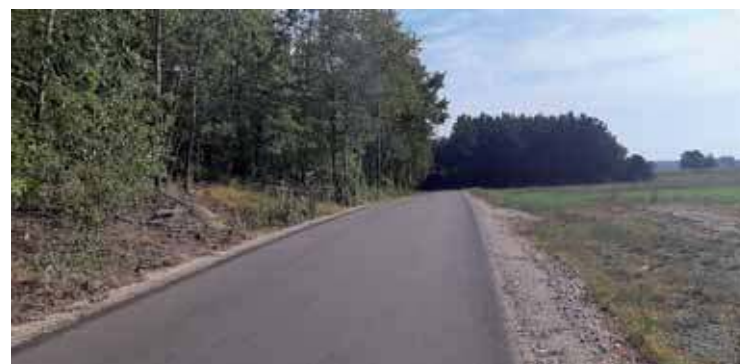
Gmina Baranowo - Usprawnienie połączeń komunikacyjnych poprzez przebudowę dróg gminnych Zawady - Zabiocha - Karaska; Rupin - Cierpięta - Rycica oraz Cierpięta - Czechronka
