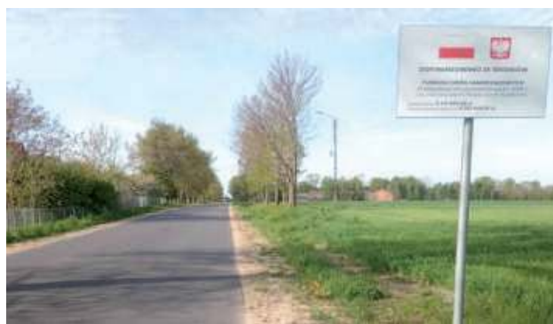
Droga Rusiły-Kodeńce po przebudowie
