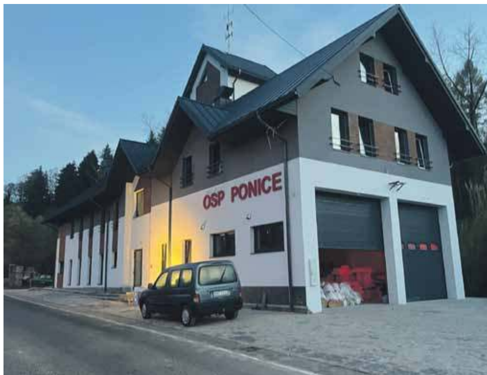
Nowy budynek remizy strażackiej na pewno będzie dobrze służyć druhom ochotnikom.
