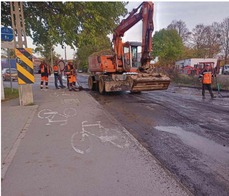
Remont ul. Sportowej właśnie się rozpoczął
