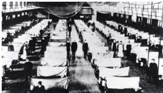
Magazyn przekształcony na miejsce kwarantanny, 1918 r.
