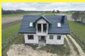
Dom w stanie surowym otwartym, Wólka Siemieńska, 885 851 160
