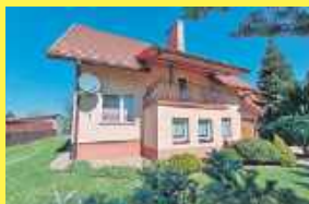
Dom przy ulicy Wyzwolenia, pow. 157,60 m 2 , 604 494 489
