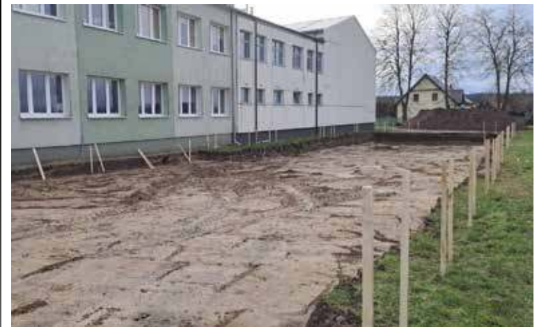
Teren przygotowany pod budowę (fot. Gm. Goleniów)
