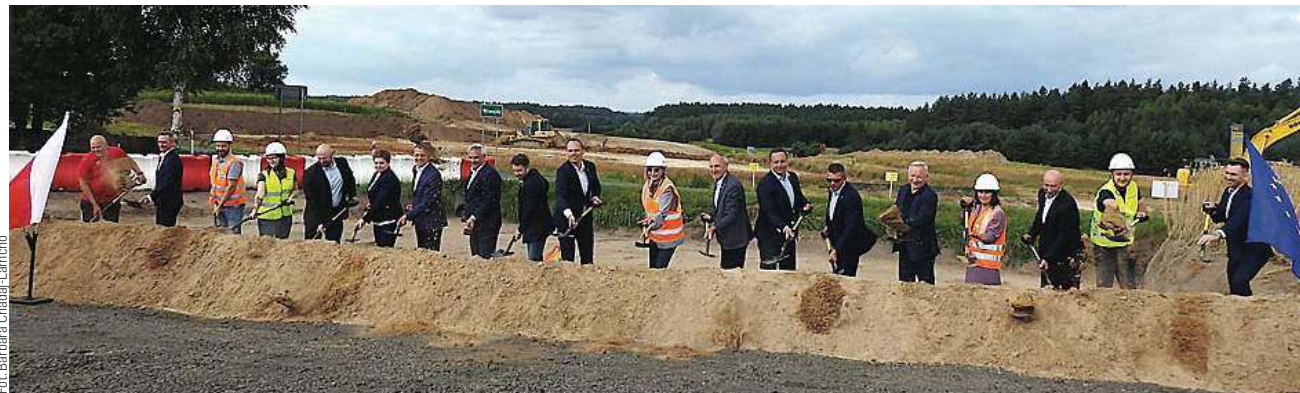
Symboliczne wbicie łopat(y) na rozpoczęciu budowy nowego odcinka S5
