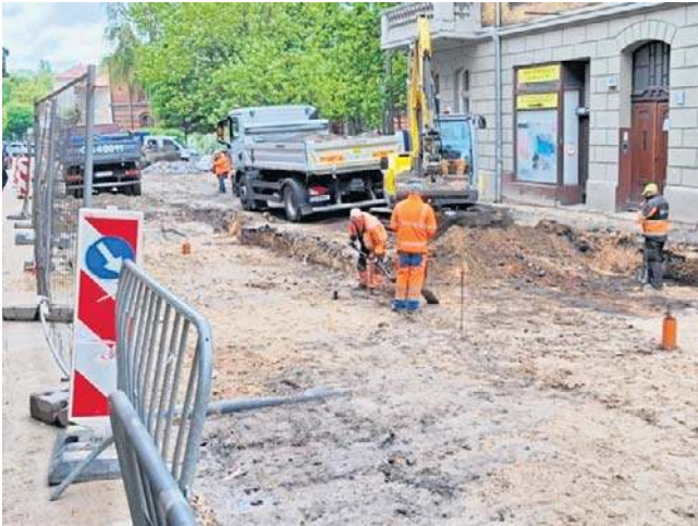
Prace na ul. Kosynierów Gdyńskich prowadzi Prasbet
