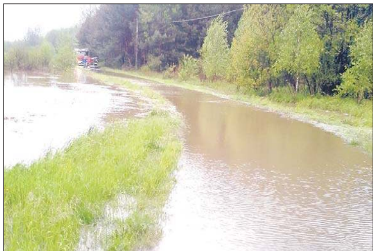
Groźnie było m.in. w Żdżarach, gdzie zalało odcinek lokalnej drogi.
