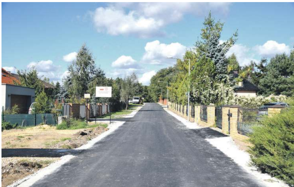
Na ulicy Kalinowej w Malinie została już położona nawierzchnia bitumiczna oraz wykonano zjazdy i dojeżdża do posesji
