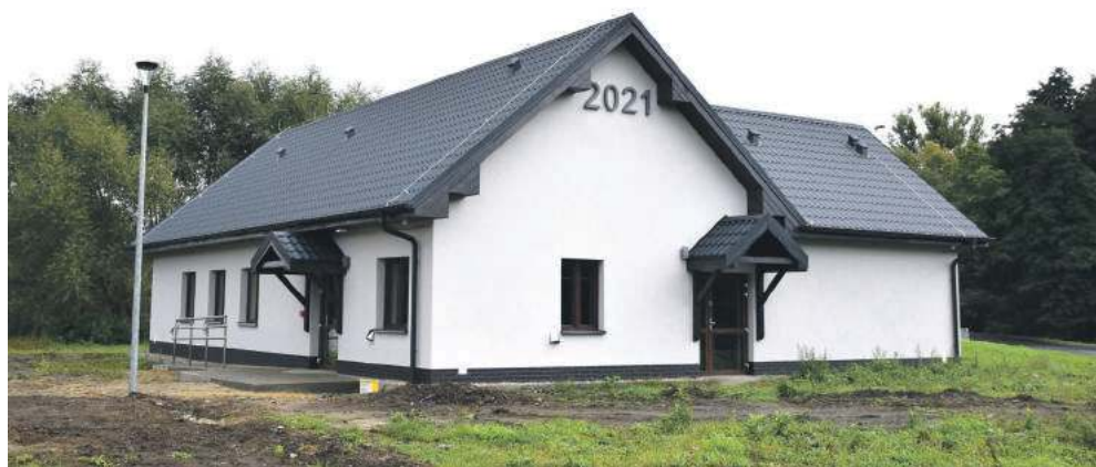
Budowa świetlicy w Pierwoszowie dobiegła końca
