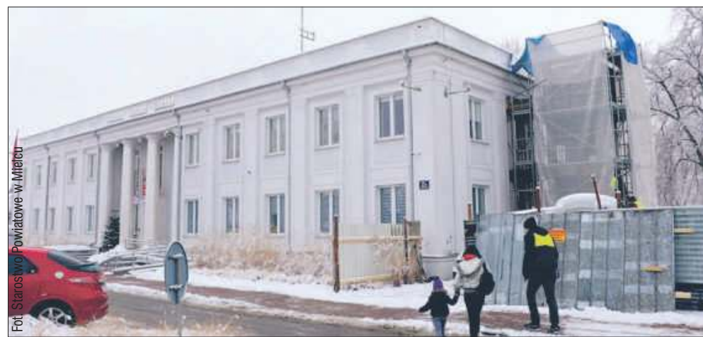
Na jednej ze ścian bocznych budynku przy ul. Sękowskiego 2B powstaje winda.
