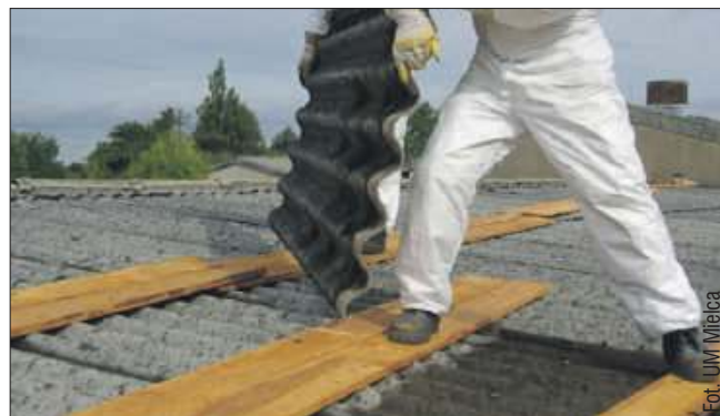
W Mielcu wciąż można składać wnioski o usunięcie wyrobów zawierających azbest, głównie płyt eternitowych z dachów.
