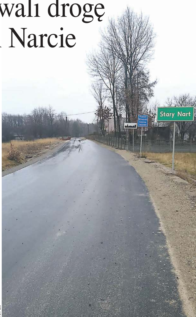
Budowa drogi kosztowała nieco ponad 381 tysięcy złotych
