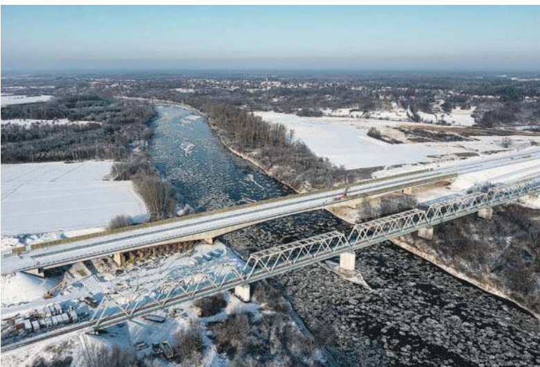
Most na Sanie w zimowej szacie. Obok most kolejowy LHS
